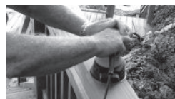
PONCAGE AVEC UN PAPIER ABRASIF DE CALIBRE 60-80
