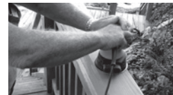
PONCAGE AVEC UN PAPIER ABRASIF DE CALIBRE 60-80
