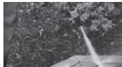
LAVER LA SURFACE À L'AIDE D'UNE LAVEUSE À PRESSION
