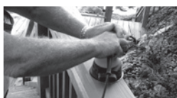
PONÇAGE DE GRAIN 120 À 180
