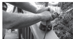
PONCAGE AVEC UN PAPIER ABRASIF DE CALIBRE 60-80
