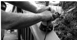
LIJADO DE ACABADO #60-#80 GRIT
