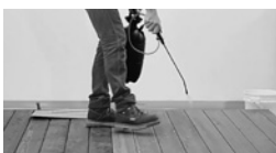
APLIQUE SDF DE SANSIN DE FORMA PAREJA CON LA BROCHA O ROCIADOR
